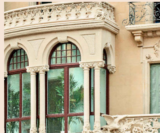
Fachada rehabilitada del edificio situado en la calle Girona, 2.
